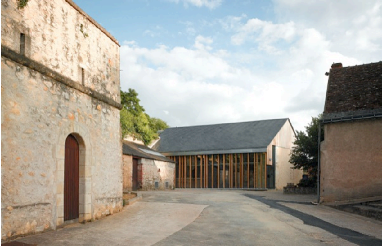
Vue de la grange viticole réhabilitée en salle de dégustation, Vouvray (37). ©Philippe Tardits architecte, photo Benoît Faure
