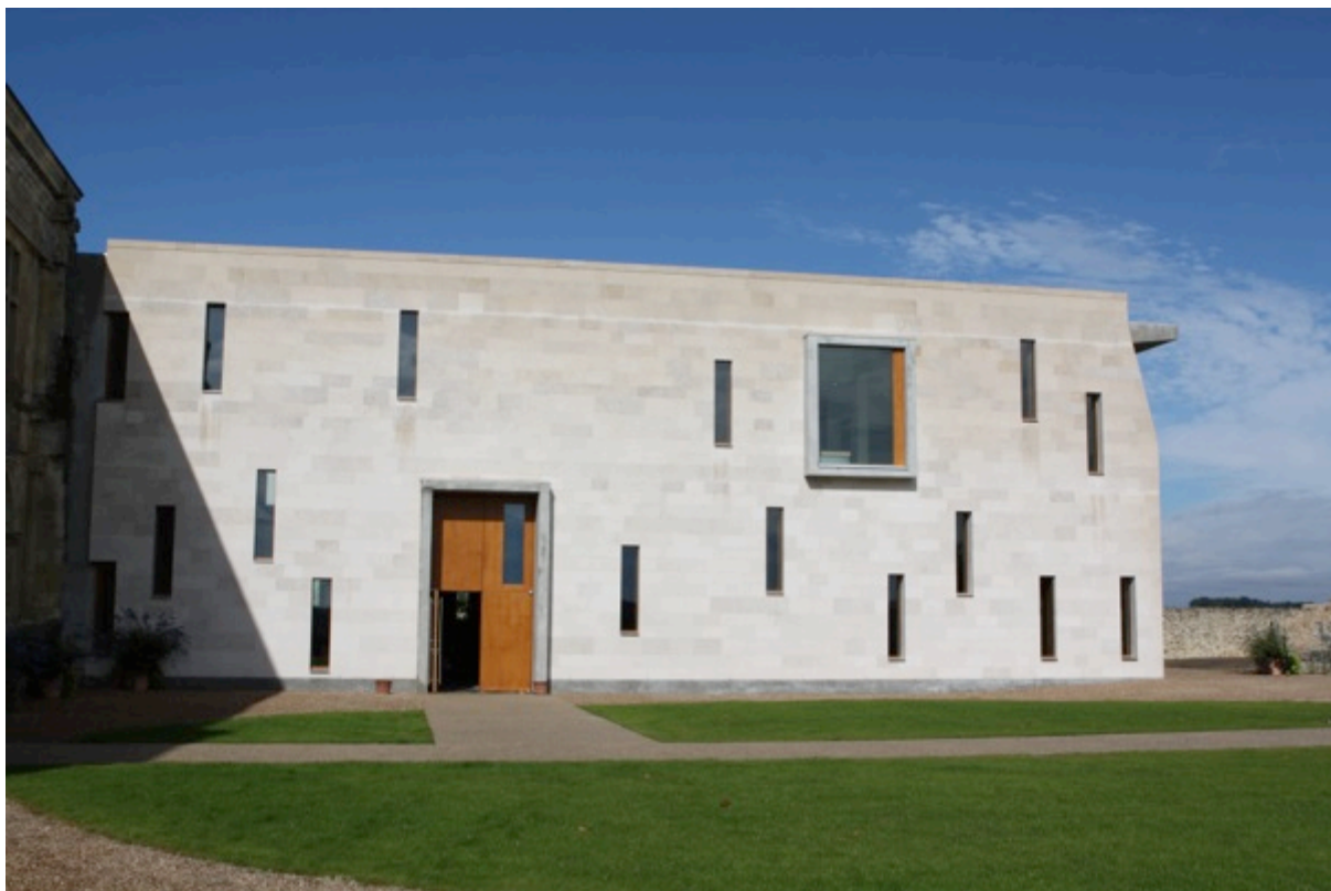
Vue de l'insertion du nouveau bâtiment dans l'ensemble du Musée de la préhistoire du Grand-Pressigny (37), 2009. ©Bernd Hoge
